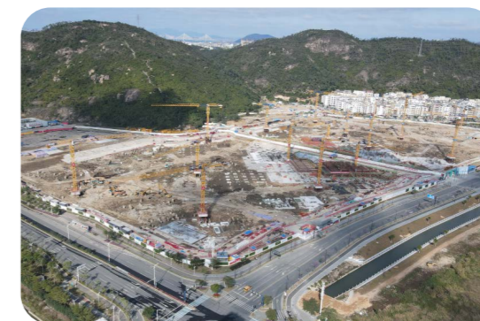
「澳门新街坊」项目工程如火如荼
