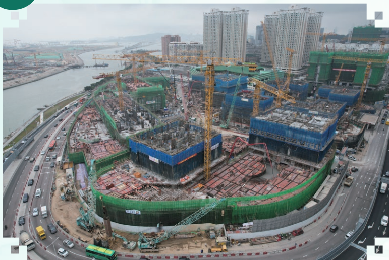
黑沙灣新填海區「P」地段暫住房項目全面開展裙樓結構施工
