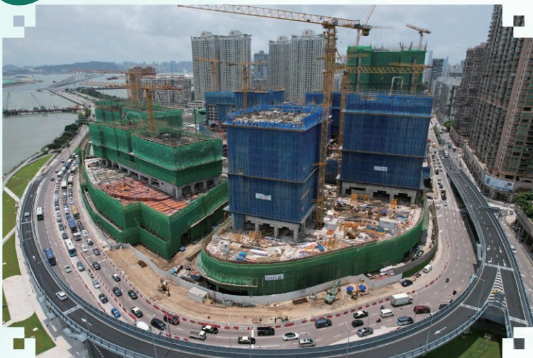
暫住房項目全面開展標準層塔樓 施工
