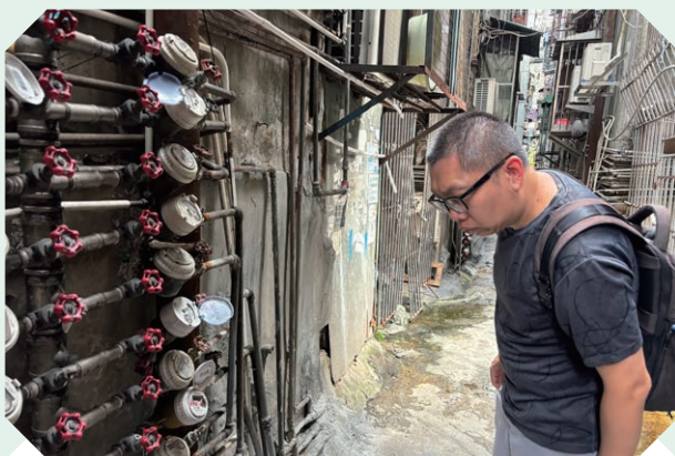
都更團隊定期對祐漢各棟樓宇進行現場勘查
