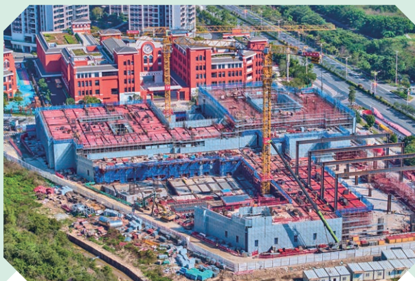
Escola Secundária do “Novo Bairro de Macau”
